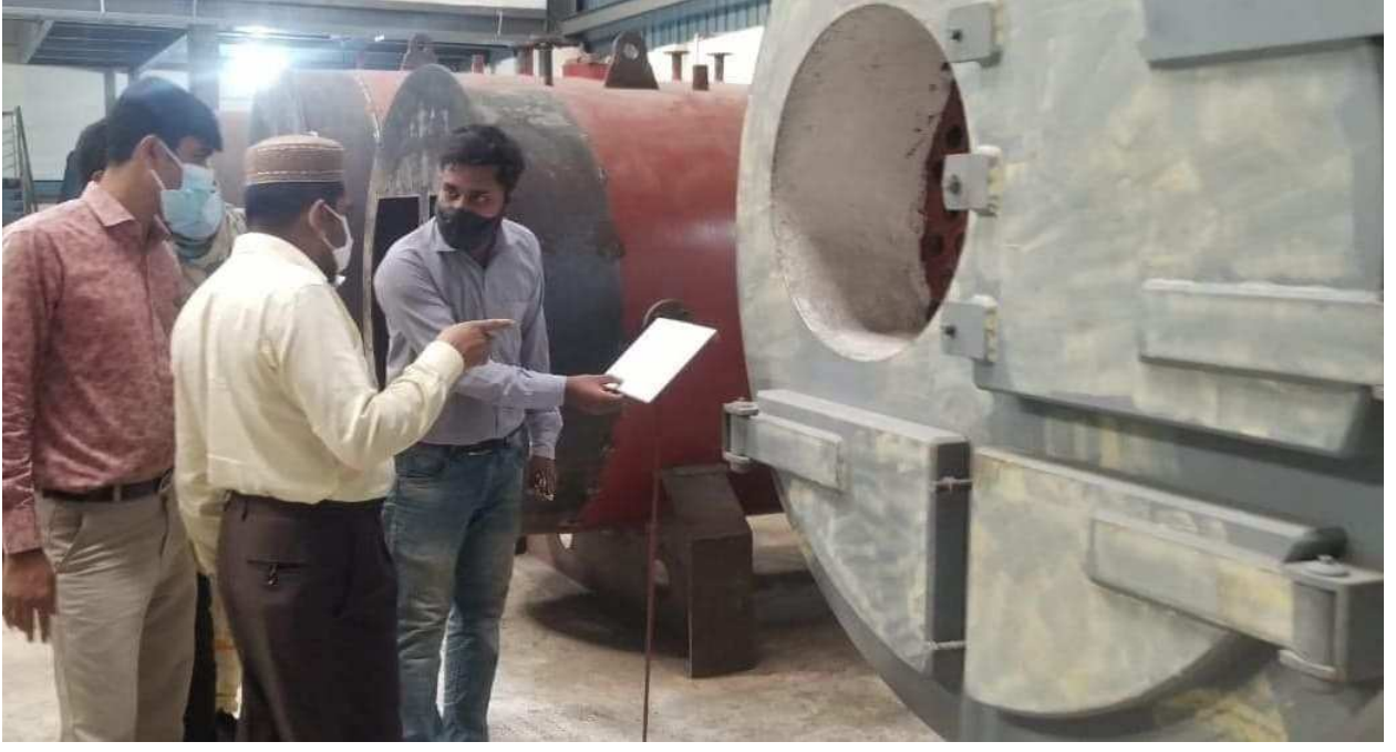
বয়লারের নির্মাণকালীন পরিদর্শন
