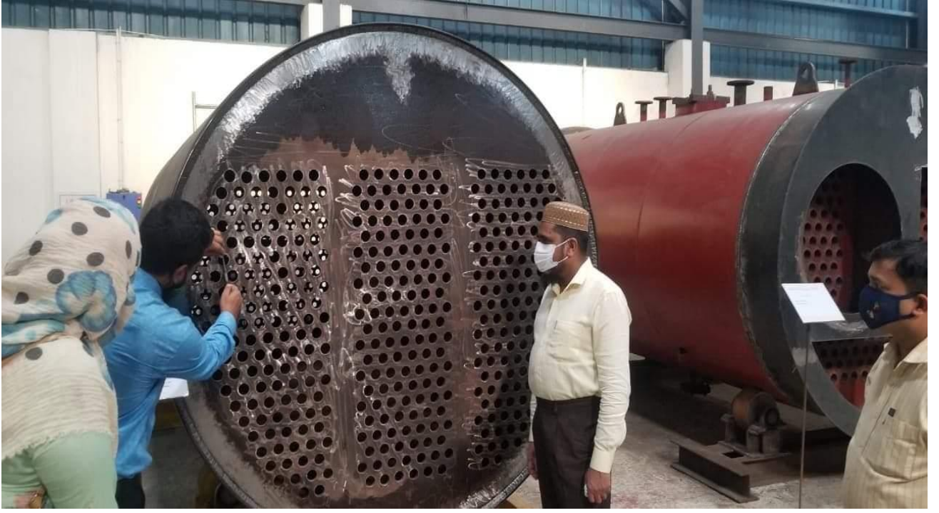
বয়লার নির্মানকালীন পরিদর্শন
