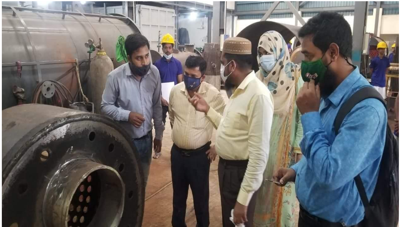
বয়লার নির্মানকালীন পরিদর্শন
