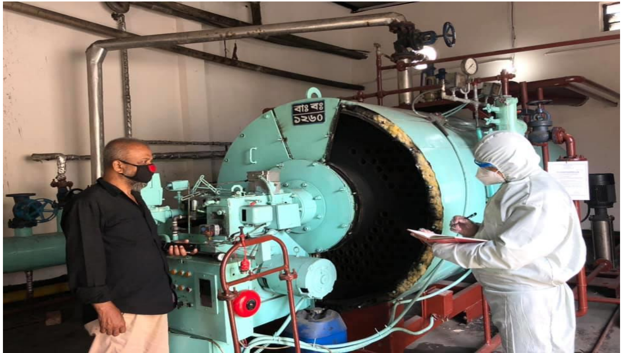
করোনাকালীন সময়ে যথাযথভাবে স্বাস্থ্য বিধি মেনে বয়লার পরিদর্শন
