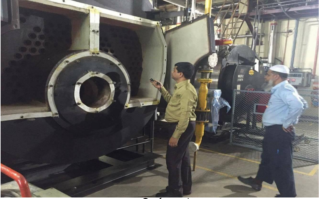
বয়লার পরিদর্শনের ফটোগ্রাফ
